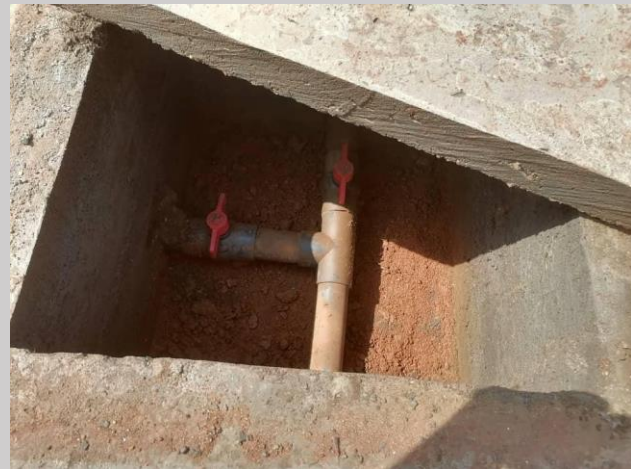
b) 1.7km pipeline
